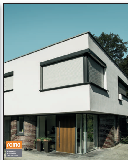
Rollladensystem in der Fassade integriert
