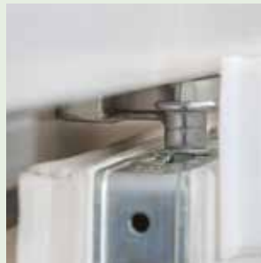
Sicherheitsschließstücke und Pilzzapfen
