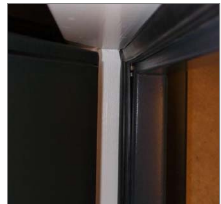
Zweite zusätzliche Dichtung am Blendrahmen
