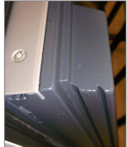
Beifalz wetterseitig am Flügel und zweite Tropfnase am Wetterschenkel
